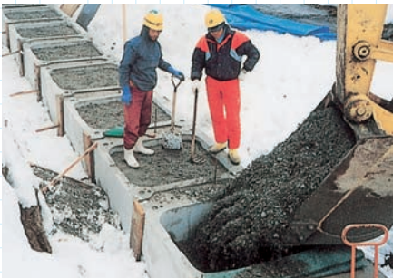
③ 中詰土砂（碎石）充填転圧
