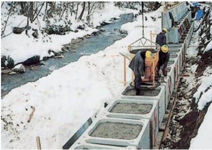
② 型枠設置後、胴込コンクリート打設 ボックスの両端部はボルト等で固定するか、 中詰土砂（碎石）を先に充填しておく。
