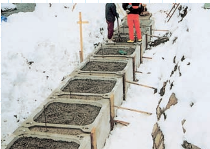
④ 埋戻し、用心鉄筋施設
