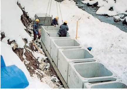
① 基礎コンクリート打設後、1 段目ボックス据付
