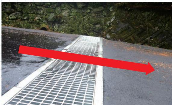
車両走行時、勾配の変化により走行がスムーズではなくグレーチングに大きな衝撃がかかりコンクリート破損の原因となります。
