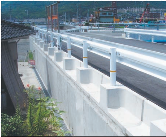
3. 補強土壁工上部に施工
