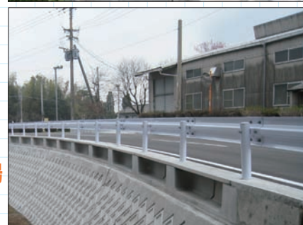
●天端目隠し版を設置した施工例です。
